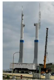
H3 発射台(工事中)
