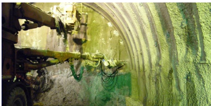
写真 1 施工状況の一例
