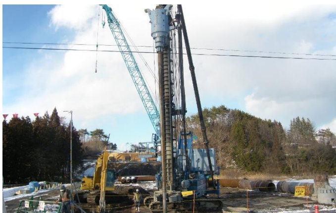
写真 2 基礎杭施工状況
