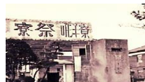
日立・成沢 吼洋寮・寮祭正門（昭和42年頃）
