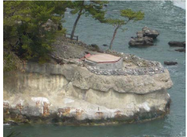
六角堂は消失し、土台だけが残った
